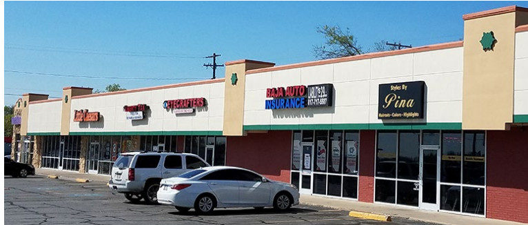
NWC OF N. MAIN & LONG (3301-3313 N MAIN ST)
