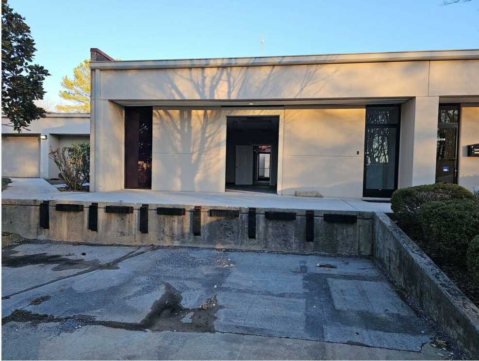
Exterior Dock High Roll-Up Door _ Suite 3000
