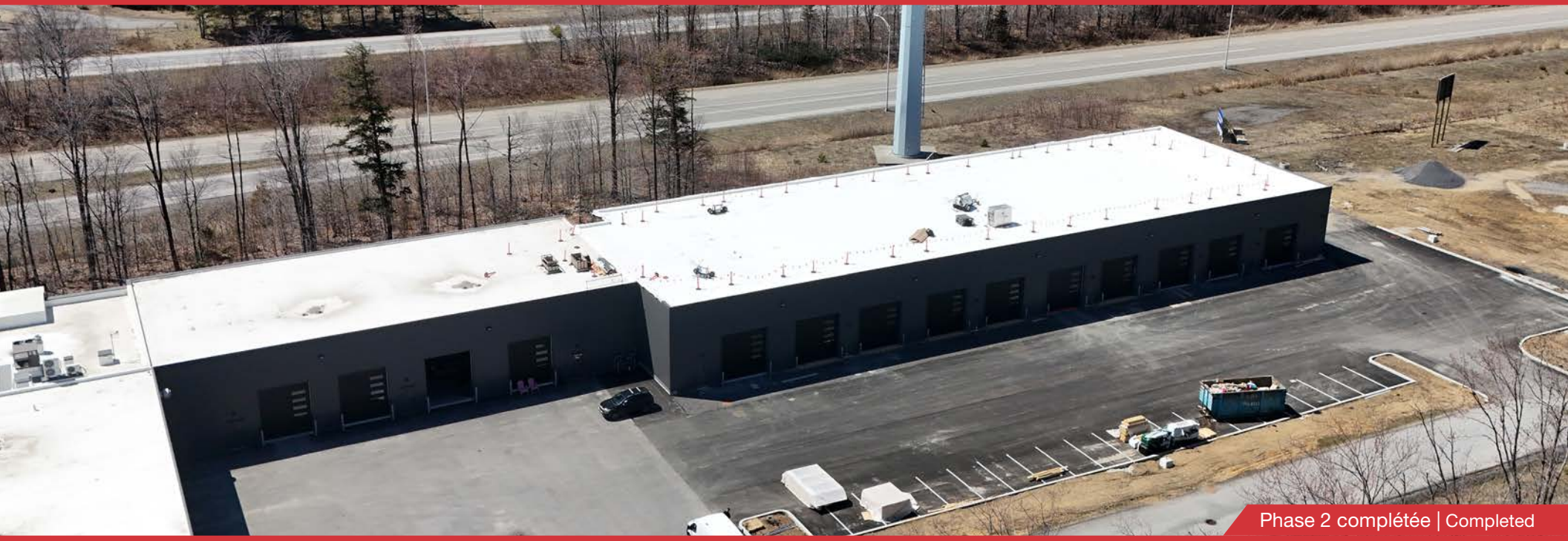
Phase 2 complétée | Completed
