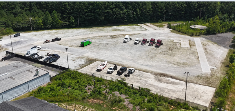
160 Maxham Rd | Austell, GA
