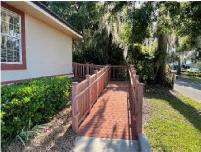
ADA ACCESS RAMP
