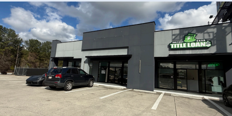
200 Maxham Rd | Austell, GA
