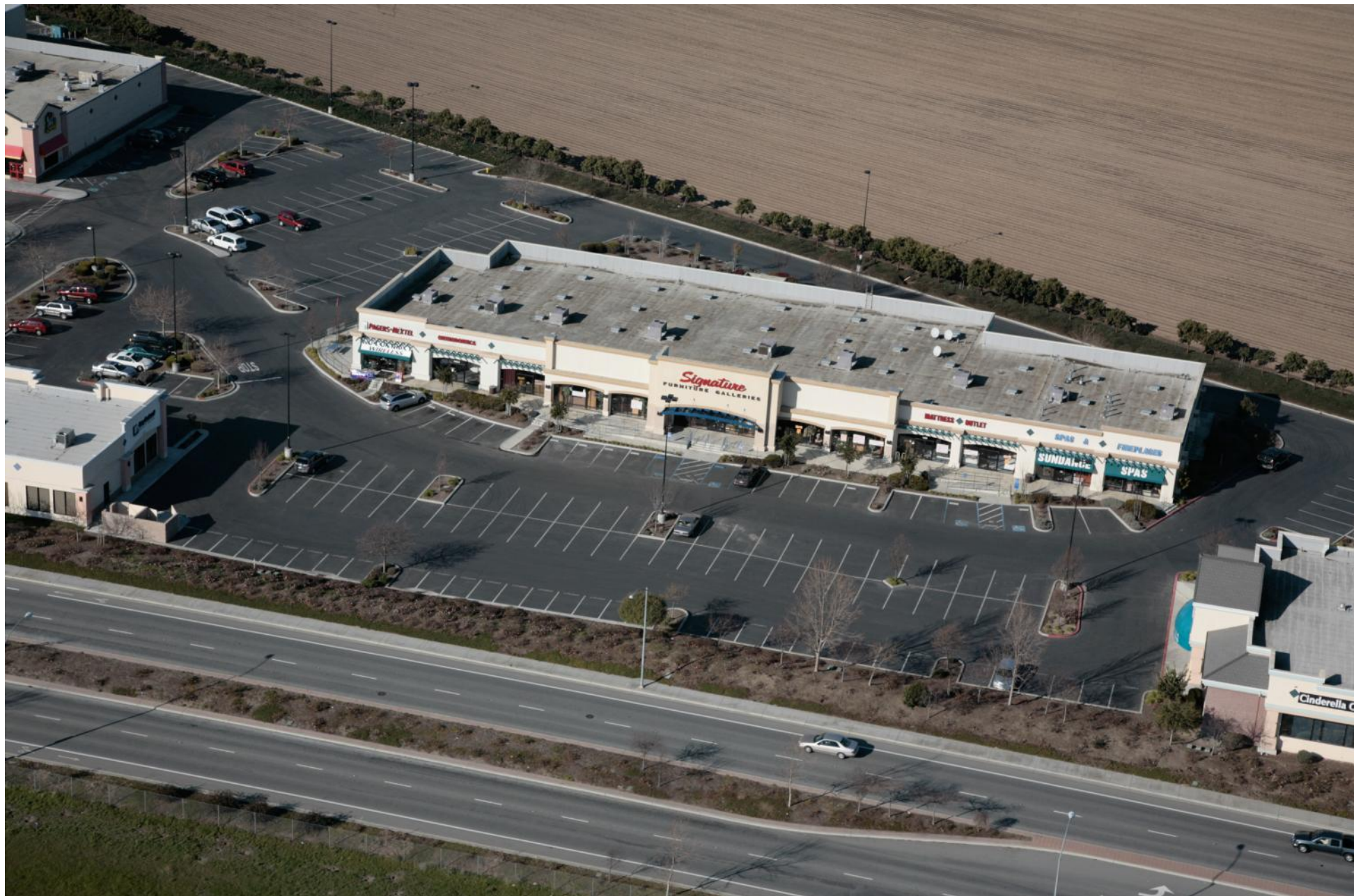
Salinas Home Center N. Davis Rd., Salinas, CA
