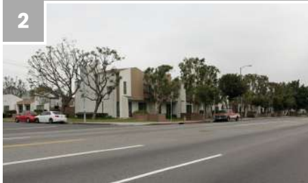
2633 S NORMANDIE AVE Los Angeles, CA 90007
