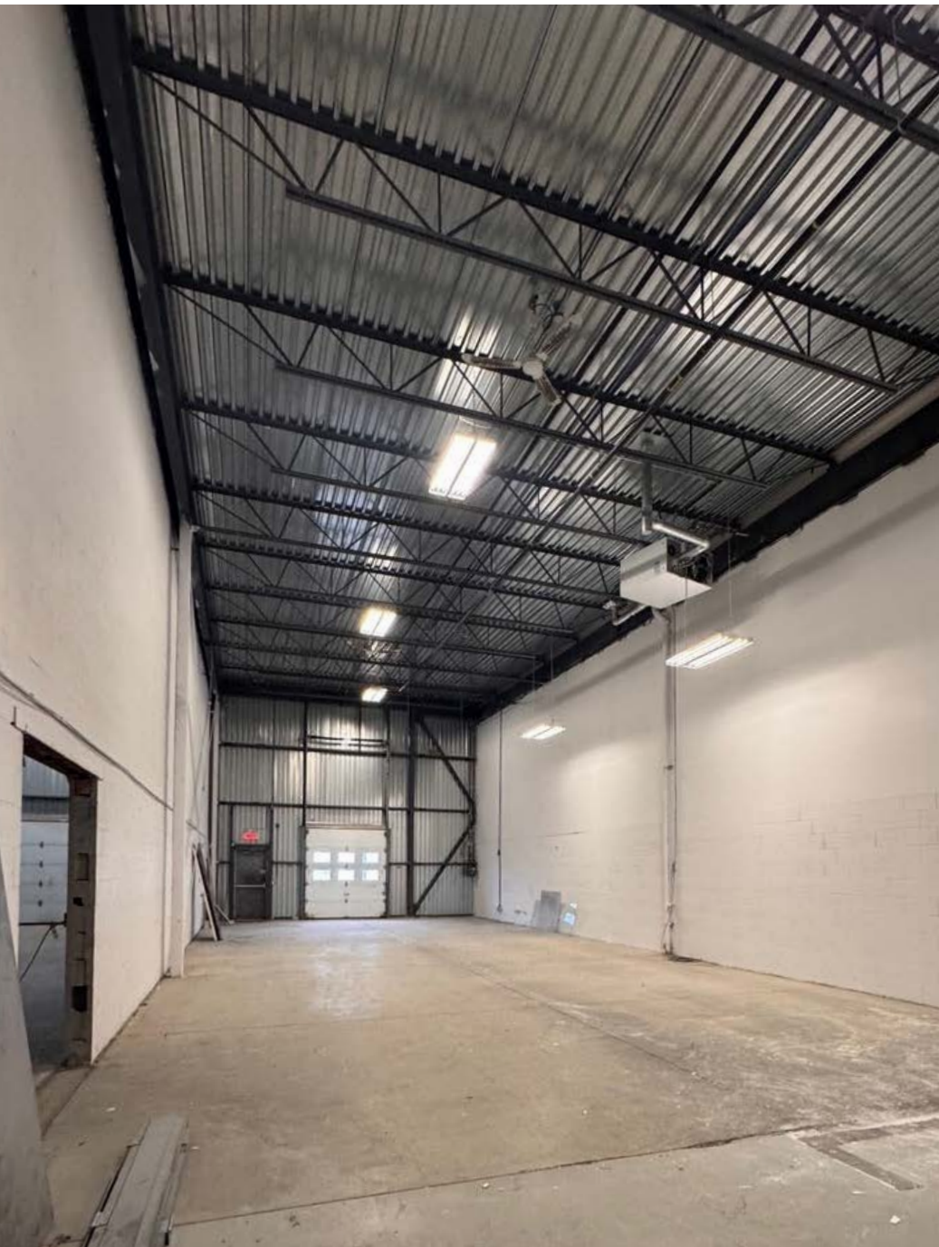
Unité | Unit 1330 Quai de chargement | Truck-Level Door
