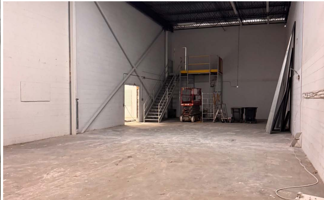
Unité | Unit 1324 Entrepôt | Warehouse
