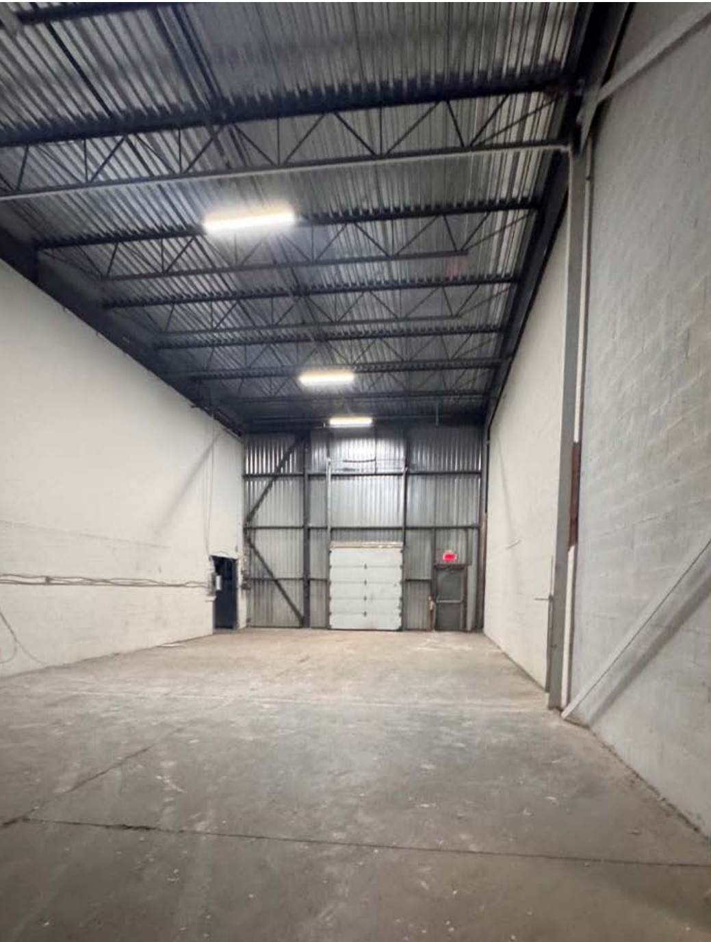
Unité | Unit 1324 Quai de chargement | Truck-Level Door
