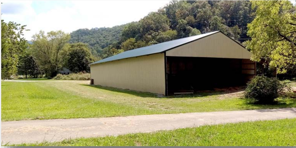
Hay Barn (Metal Construction)
