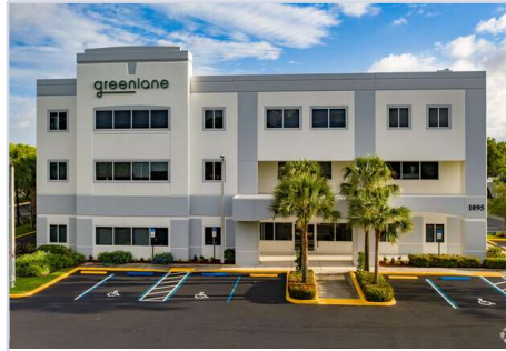
4 1095 Broken Sound Pky ↻
