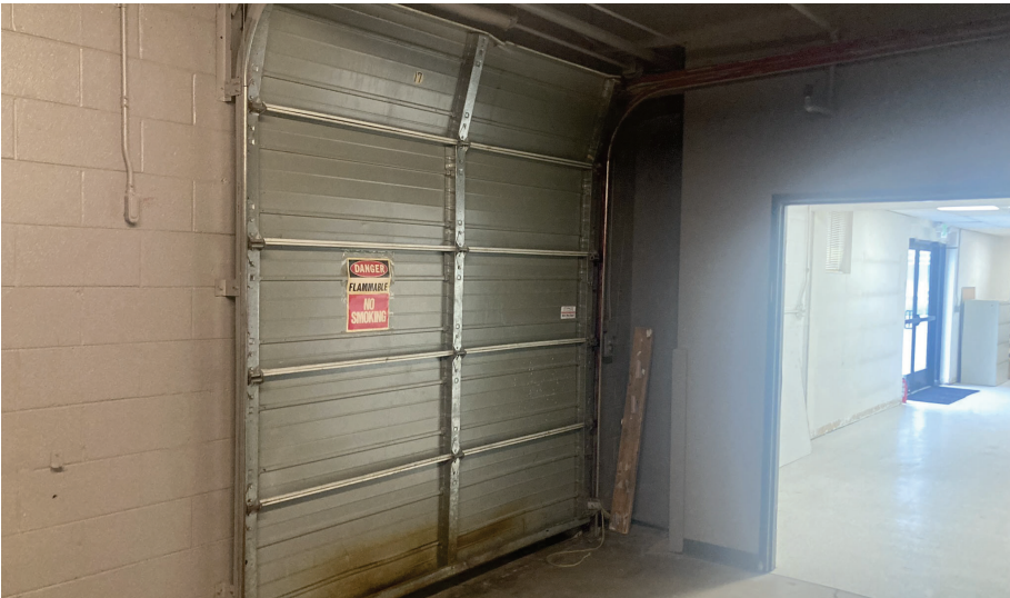
Loading Dock Door
