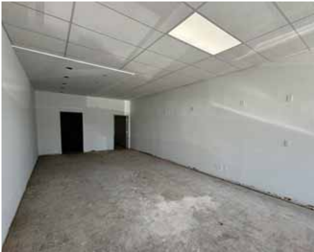
1156 N. Capitol Avenue - Interior
