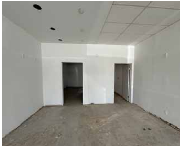
1156 N. Capitol Avenue - Interior
