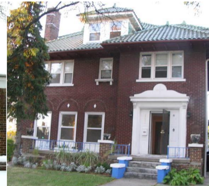
2166 Oakman Blvd. Detroit, MI
