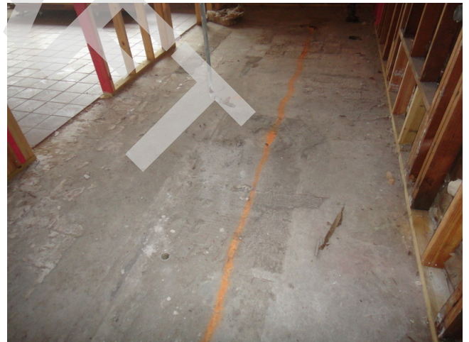
28. Concrete slab bldg 1
