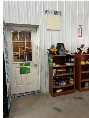
Warehouse Side Door
