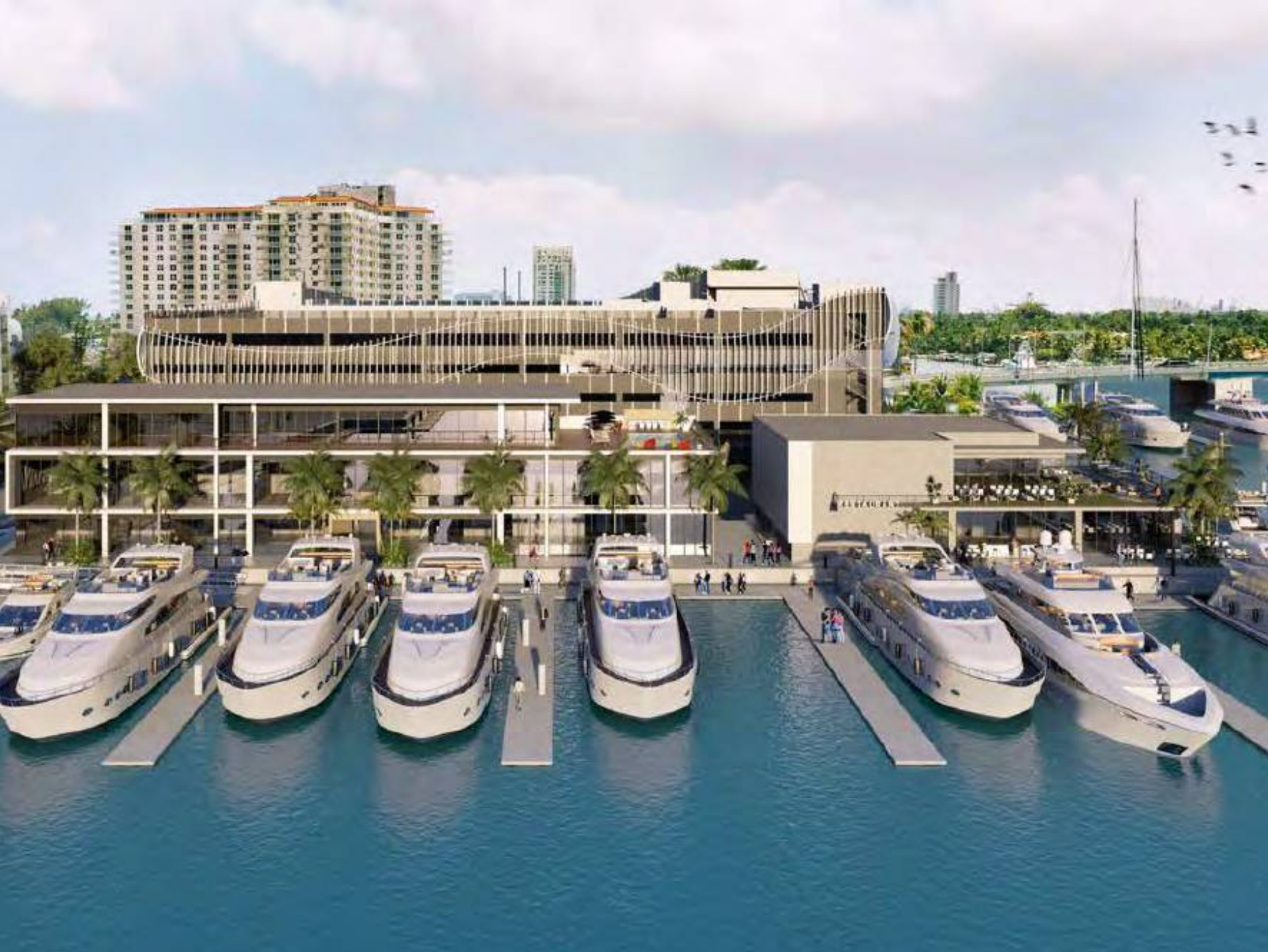
Las Olas Marina Redevelopment
