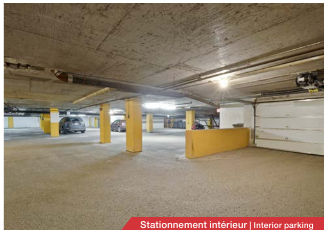
Stationnement intérieur | Interior parking
