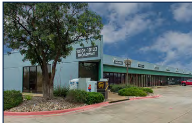
Bldg A 10103 - 10123 Broadway
