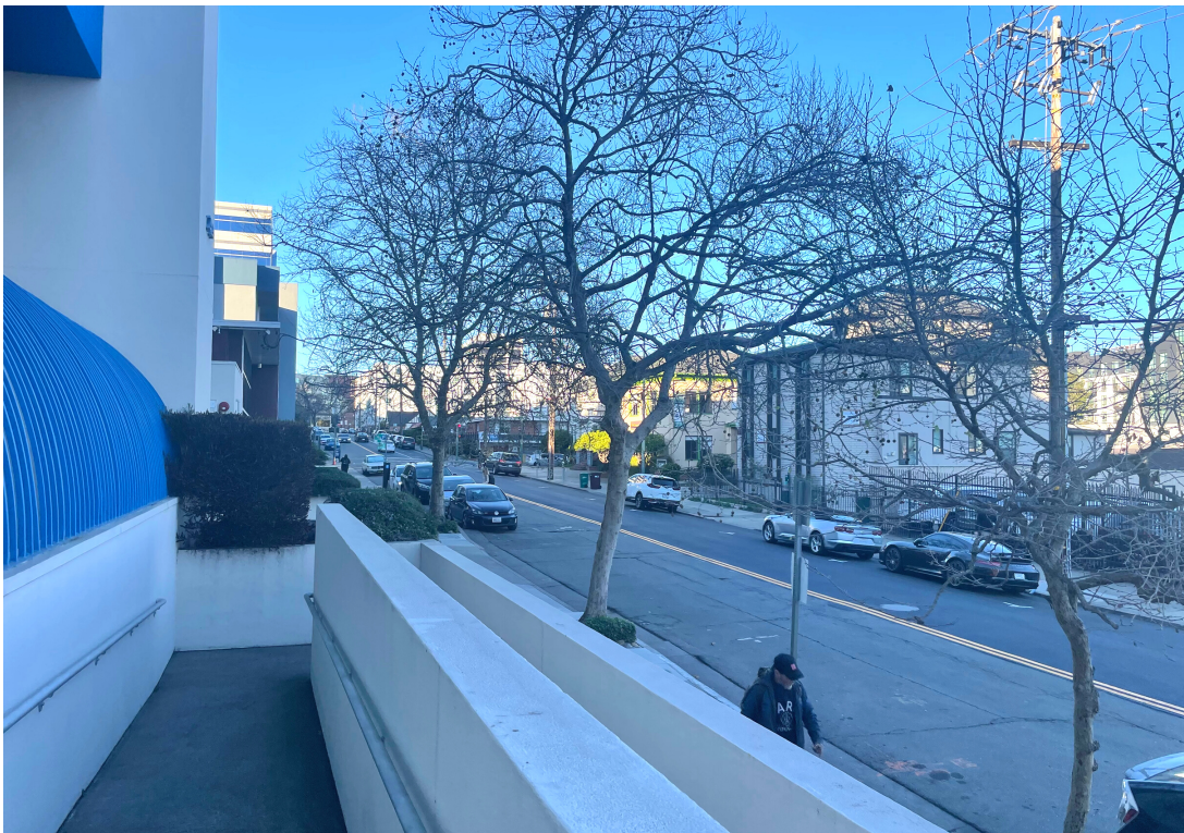
ADA Ramp Access
