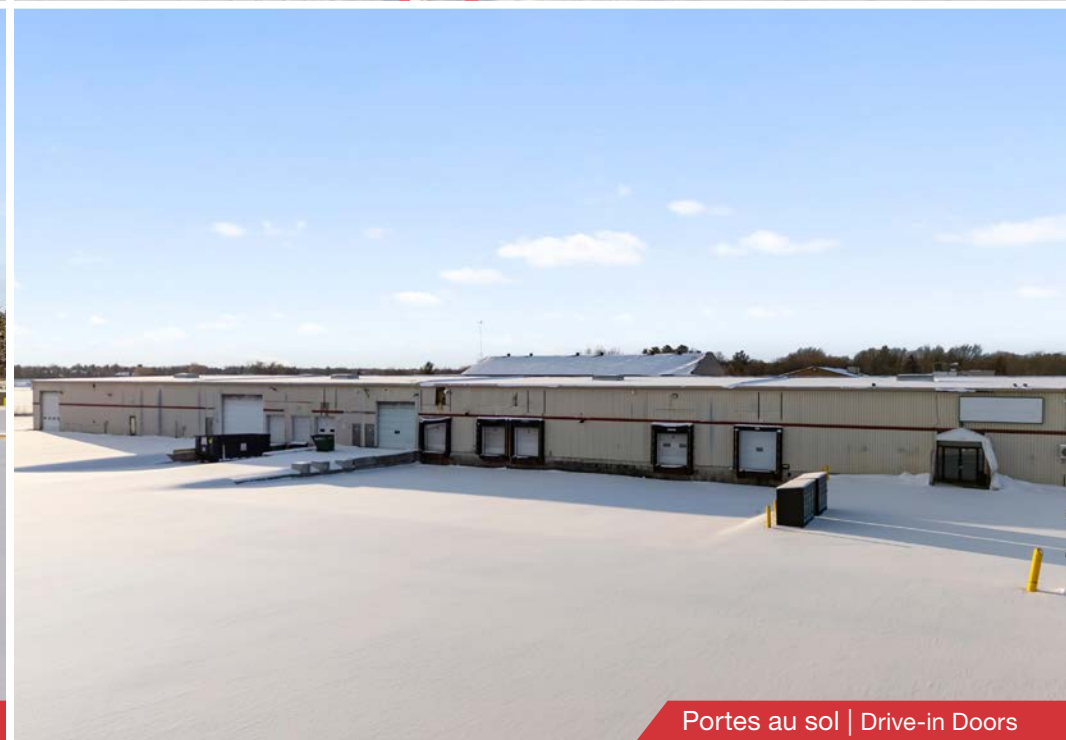
Portes au sol | Drive-in Doors
