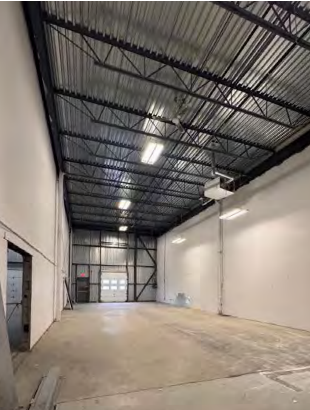
Unité | Unit 1330 Quai de chargement | Truck-Level Door
