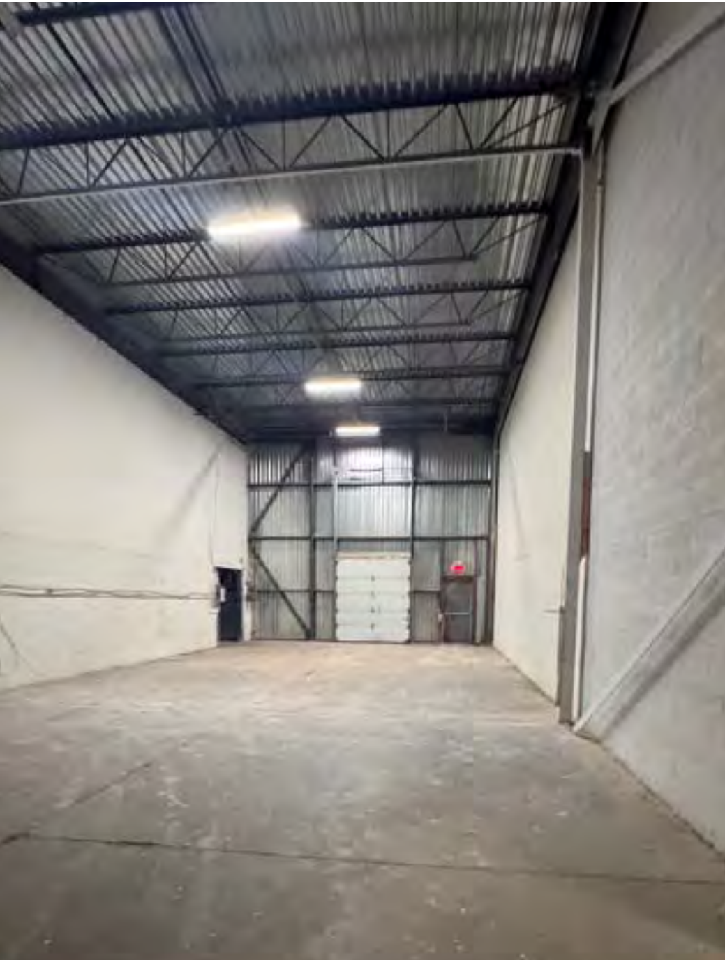
Unité | Unit 1324 Quai de chargement | Truck-Level Door
