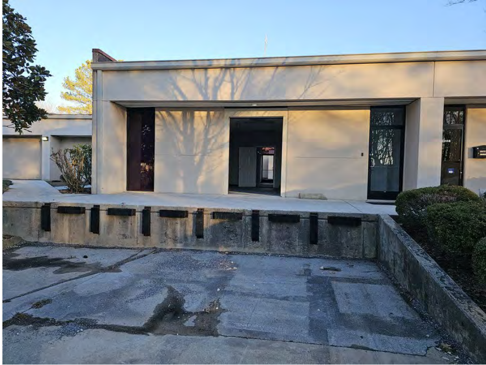
Exterior Dock High Roll-Up Door _ Suite 3000
