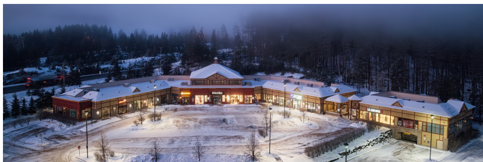
Vue aérienne - Aerial view
