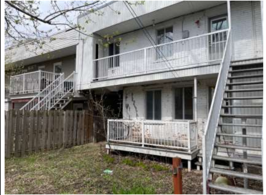
Vue générale de la cour arrière
