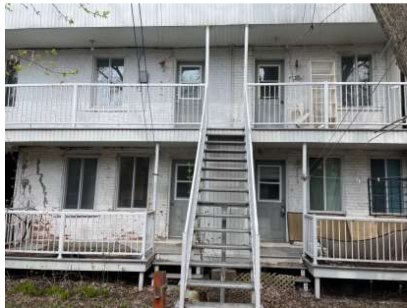
Vue générale de la façade arrière de la propriété à l'étude.
