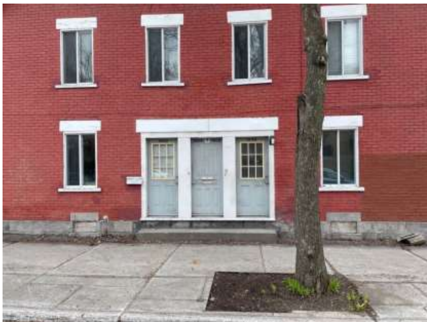
Vue générale de la façade avant de la propriété à l'étude.
