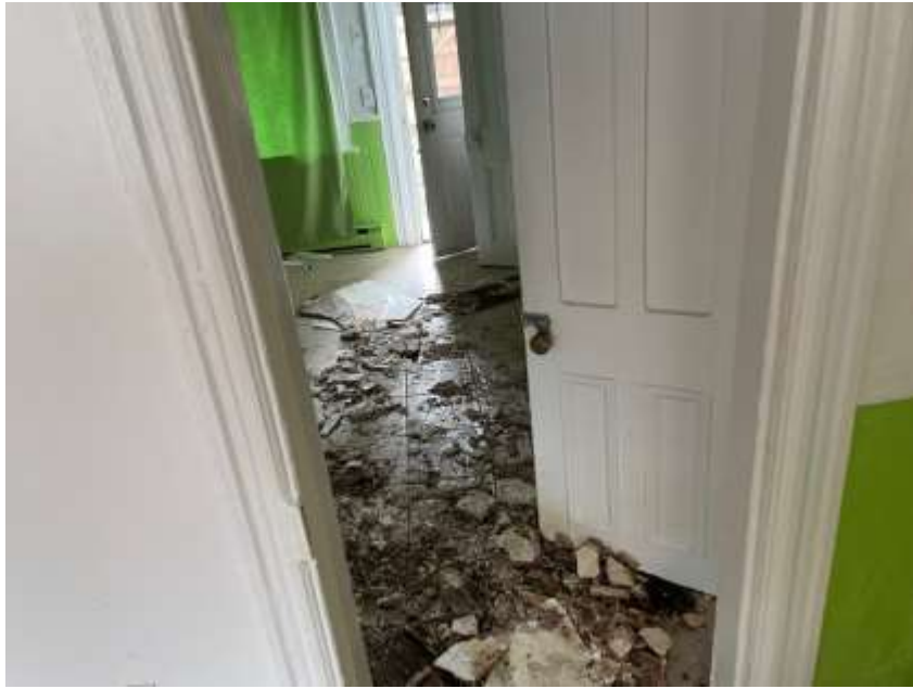
Vue générale à l'intérieur du bâtiment.
